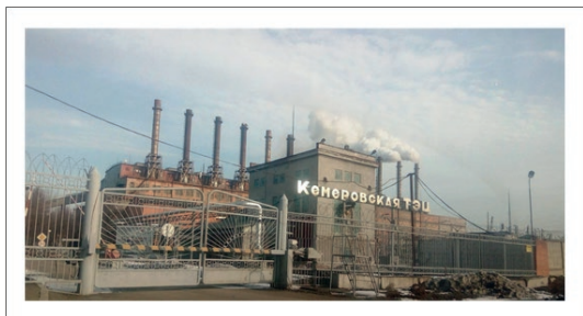
Рисунок 1 – Кемеровская ТЭЦ Figure 1 - Kemerovo CHP
