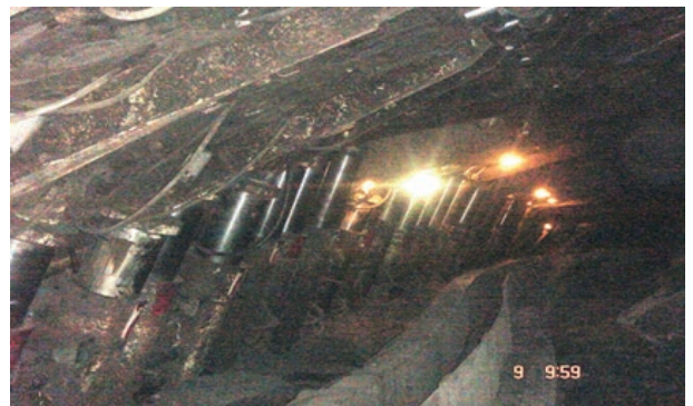
Рисунок 5. Действующая эксплуатация СМК: СМК наклонены на забой, поддерживающие и ограждающие элементы находятся на одной линии или в одной плоскости, поддерживающая способность утрачена (отсутствует) Figure 5 - The current operation of the PSS: the PSS is tilted to the face, the supporting and protective elements are on the same line, or in the same plane, supportive ability lost (absent)
